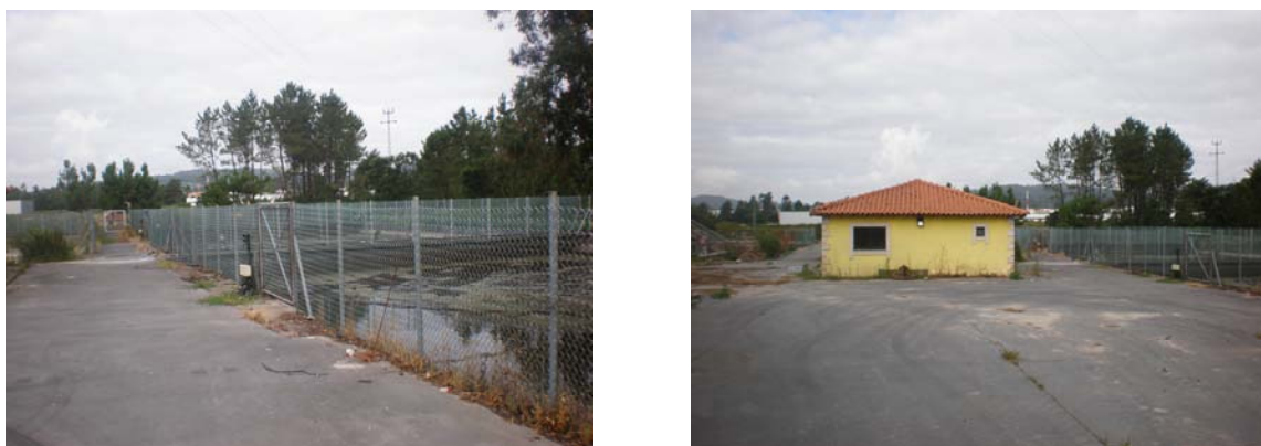
Figura 25 – Vista da ETARI e da casa de apoio à ETARI
