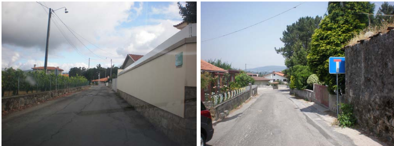
Figura 26 – Vistas do início (a partir da Rua Professor Campelo) e a meio da Rua de Freitas
